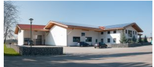
Das Gebäude mit der neuen Halle (2015)
